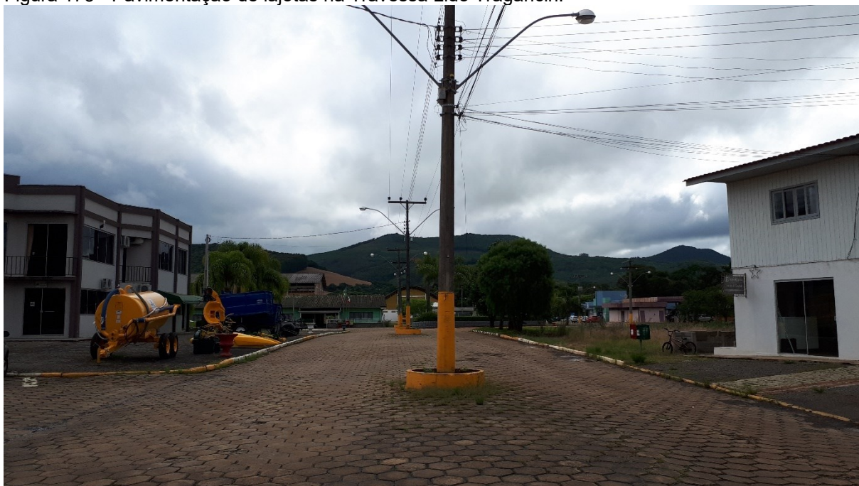
Figura 173 - Pavimentação de lajotas na Travessa Lido Tragancin.
