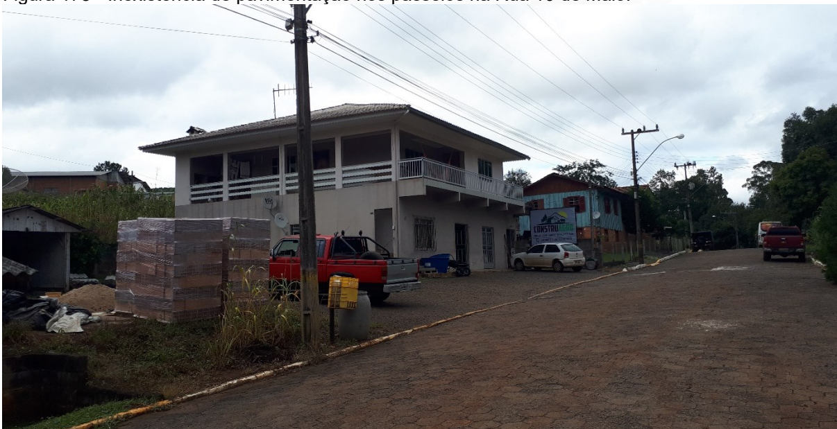
Figura 178 - Inexistência de pavimentação nos passeios na Rua 10 de Maio.
