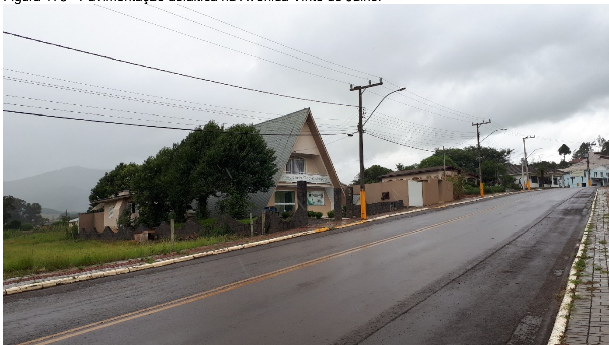
Figura 175 - Pavimentação asfáltica na Avenida Vinte de Julho.
