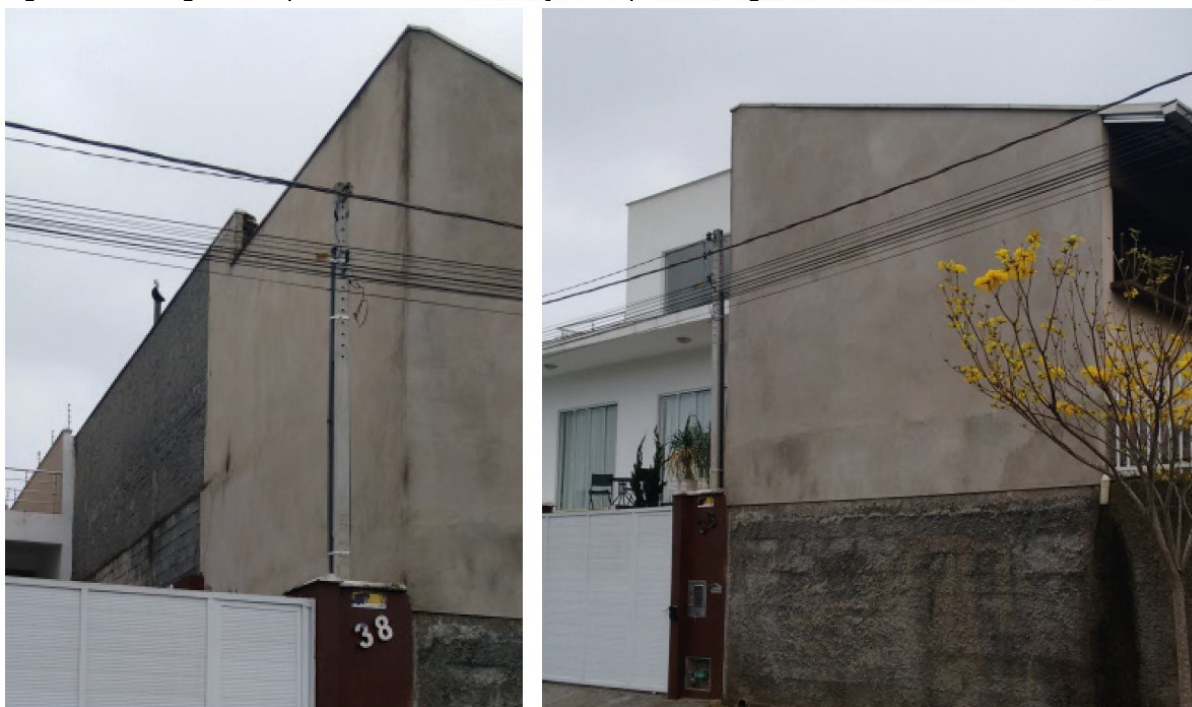
Figura 85 - Imagem da questão sobre construção de parede cegas nas divisas do lote.
